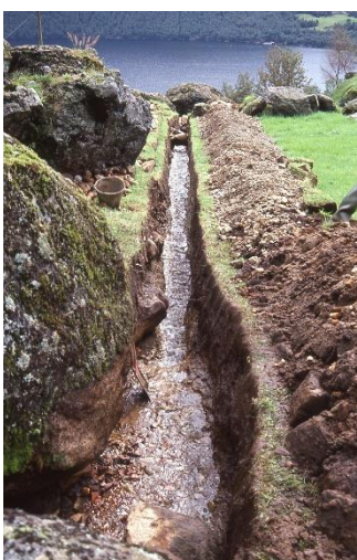
16. Dreneringsgrøfter var viktig for å leia vatn vekk frå dyrka mark. Grøftene blei greve med hand og steinsett.
